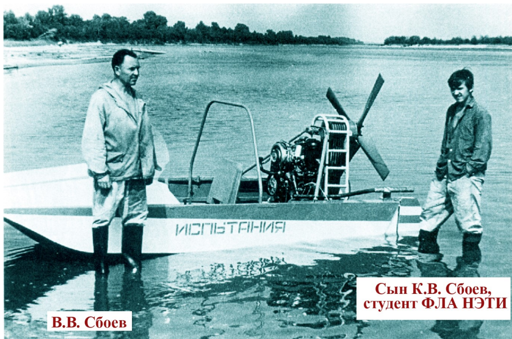
Испытания опытного образца аэросаний-амфибии на полигоне завода им. В.П. Чкалова
