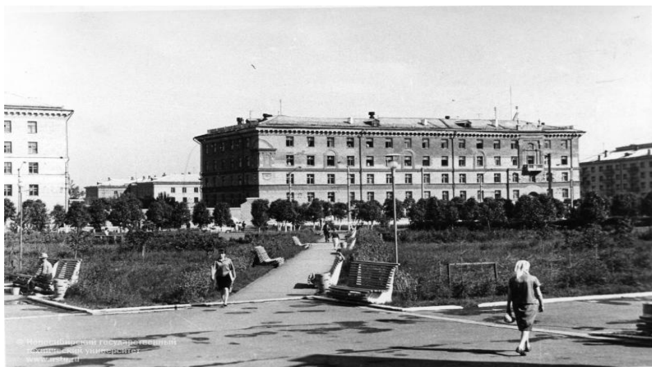
Второй учебный корпус – корпус Б. Сдан в эксплуатацию 23 сентября 1956 г. В этом же здании в 1965 г. открыт профилакторий на 75 мест. Сейчас студенческое общежитие № 2
