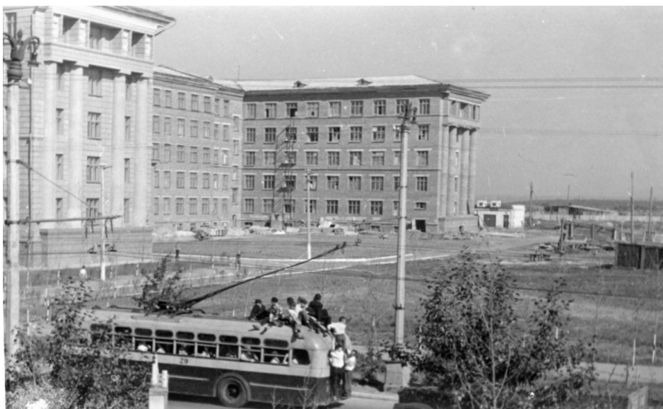
Главный корпус построен! Но транспорта не хватает! 1960 г.
