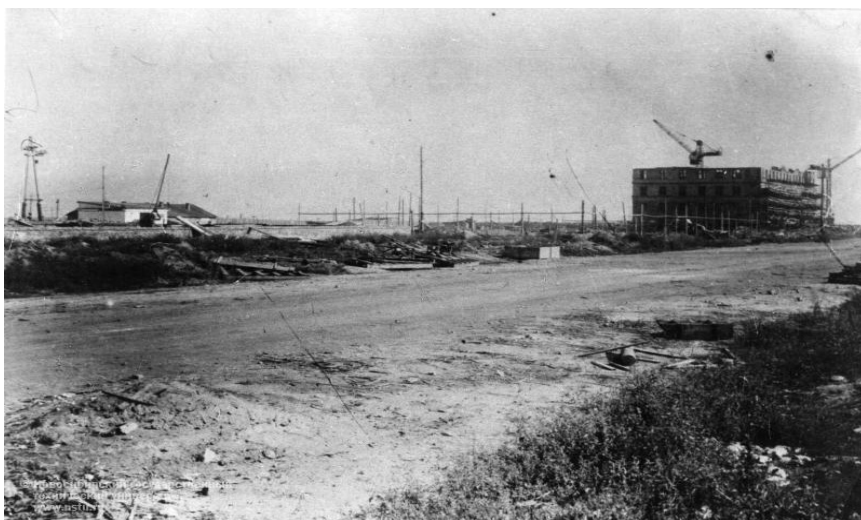
Подготовка площади для строительных работ для первого учебного корпуса НЭТИ, сданного в эксплуатацию в 1960 г.
