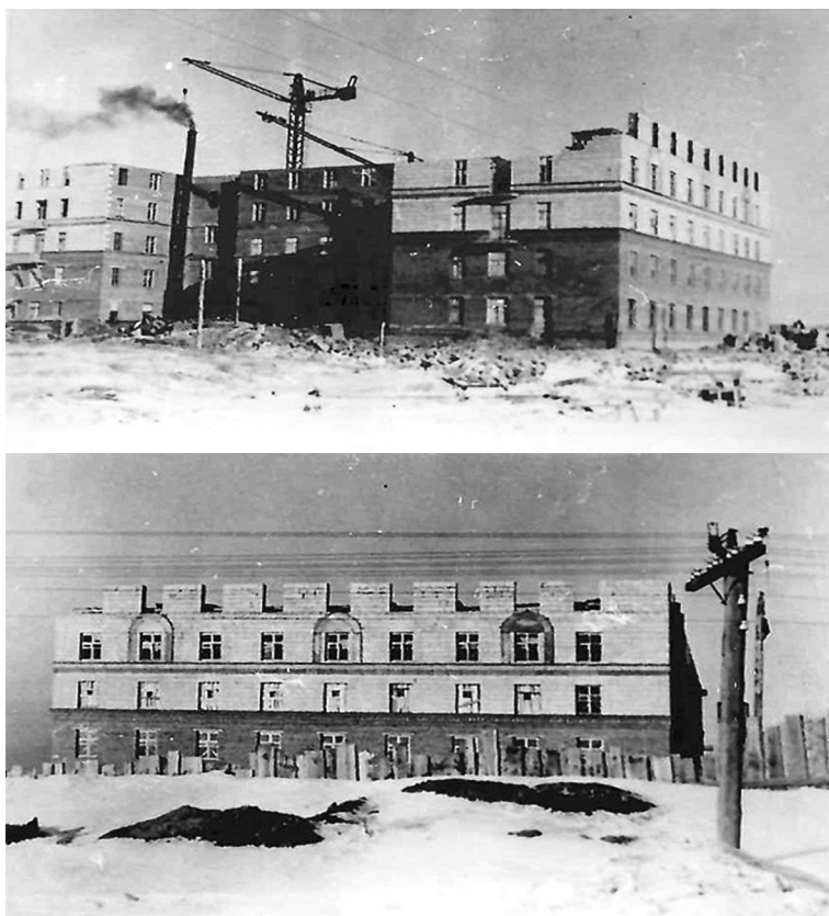
Кипят строительные работы!
